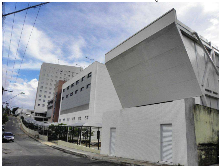
Foto 09 – No entorno do Galpão há hotel e centro comercial em obra.
