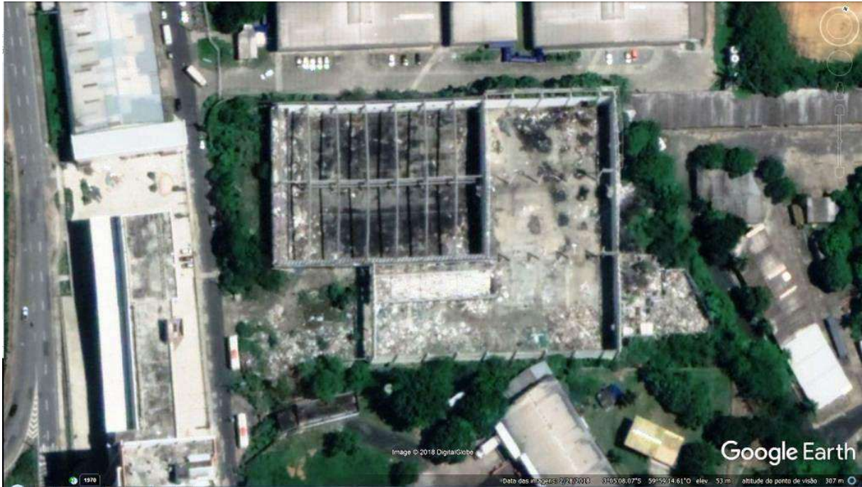
Imagem 01 – Foto de satélite mostrando destelhamento total do imóvel e grande quantidade de entulho (imagem Google Earth – em 28/02/2018)
