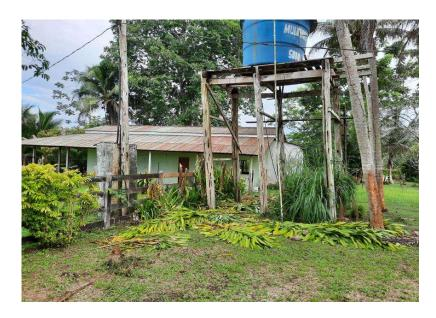
**3.** Uma caixa d'água de cinco mil litros, fabricada em fibra de vidro, suspensa por estrutura em madeira. Avaliada em R\$ 2.800,00 (Dois mil e oitocentos reais).
